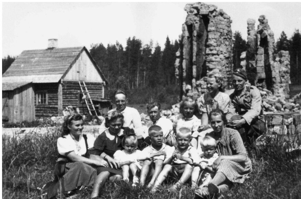
Koivuojan tilan päärakennuksen rauniot ja välirauhan aikana käytetty tilapäisasunto. Kuva vuodelta 1943.
